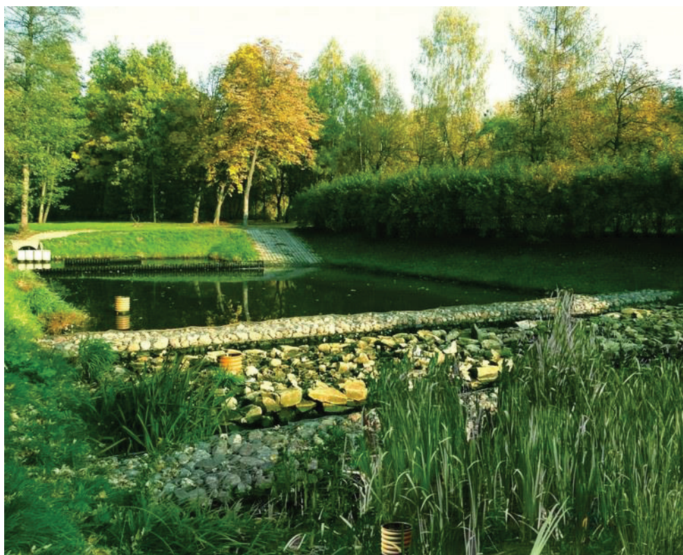
Fotografia 6. System sedymentacji sekwencyjnej biofiltracji wody opadowej
