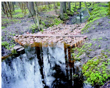
Fot. 3 i 4. Urządzenia spowalniające odpływ wody w korytach cieków: bystrotek kamienny i tama bobrowa
