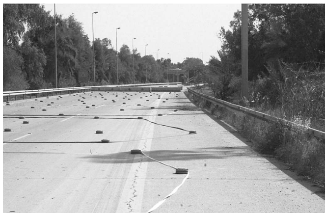
Ryc. 1. Pole narzutowe jako blokada przeciwpancerna autostrady (źródło: US Army)
